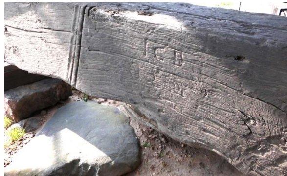
Eingeschlagene Initialen wie "ICD" und "OLW" in einer Schwelle, die entweder auf den Bauherrn oder den Baumeister schließen lassen.
